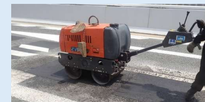
パッチングによる補修の例
