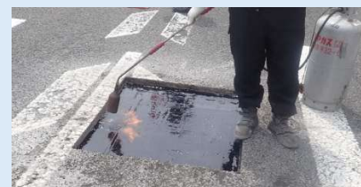
パッチングによる補修の例
