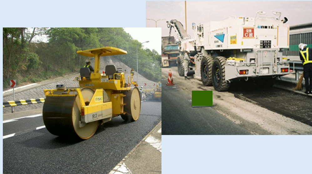
切削オーバーレイによる補修
