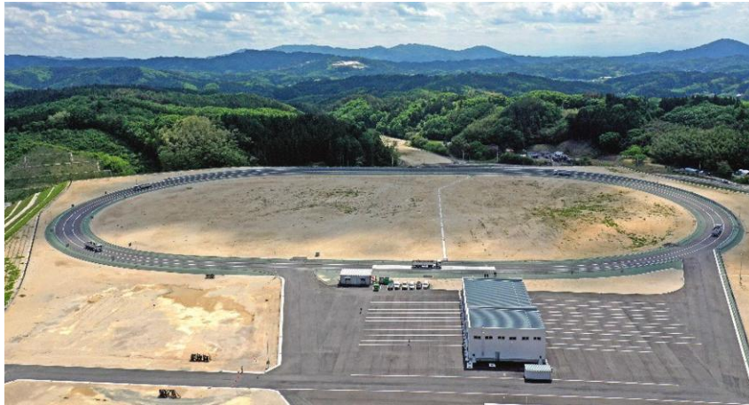
次世代舗装実験施設 舗装のテストコース (大成ロテック提供)
