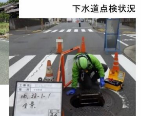
下水道点検状況
