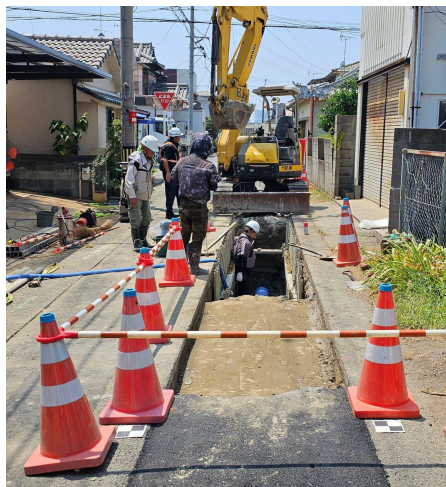
和歌山市(下水工事)
