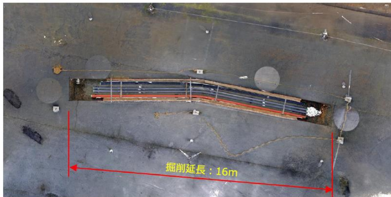
写真：製作した地下埋設試験フィールド（上空全景）
