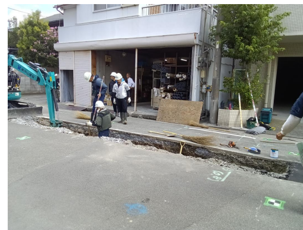
和歌山市(上水工事)
