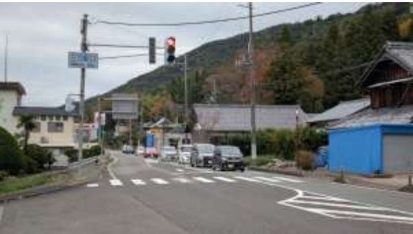
①三方駅口交差点 敦賀方面から小浜に向かって 下り勾配
