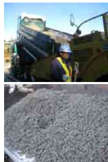
写真9-42 砕石粉Aのフィニッシュへの荷下ろし
