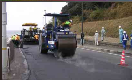
試験施工状況(国道28号下り線釜口地区)
