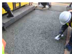
写真9-43 砕石粉Aの場合のフィニッシュによる施工風景
