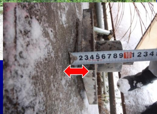
変状箇所では、頭部露出後プレートの浮きが確認された。
