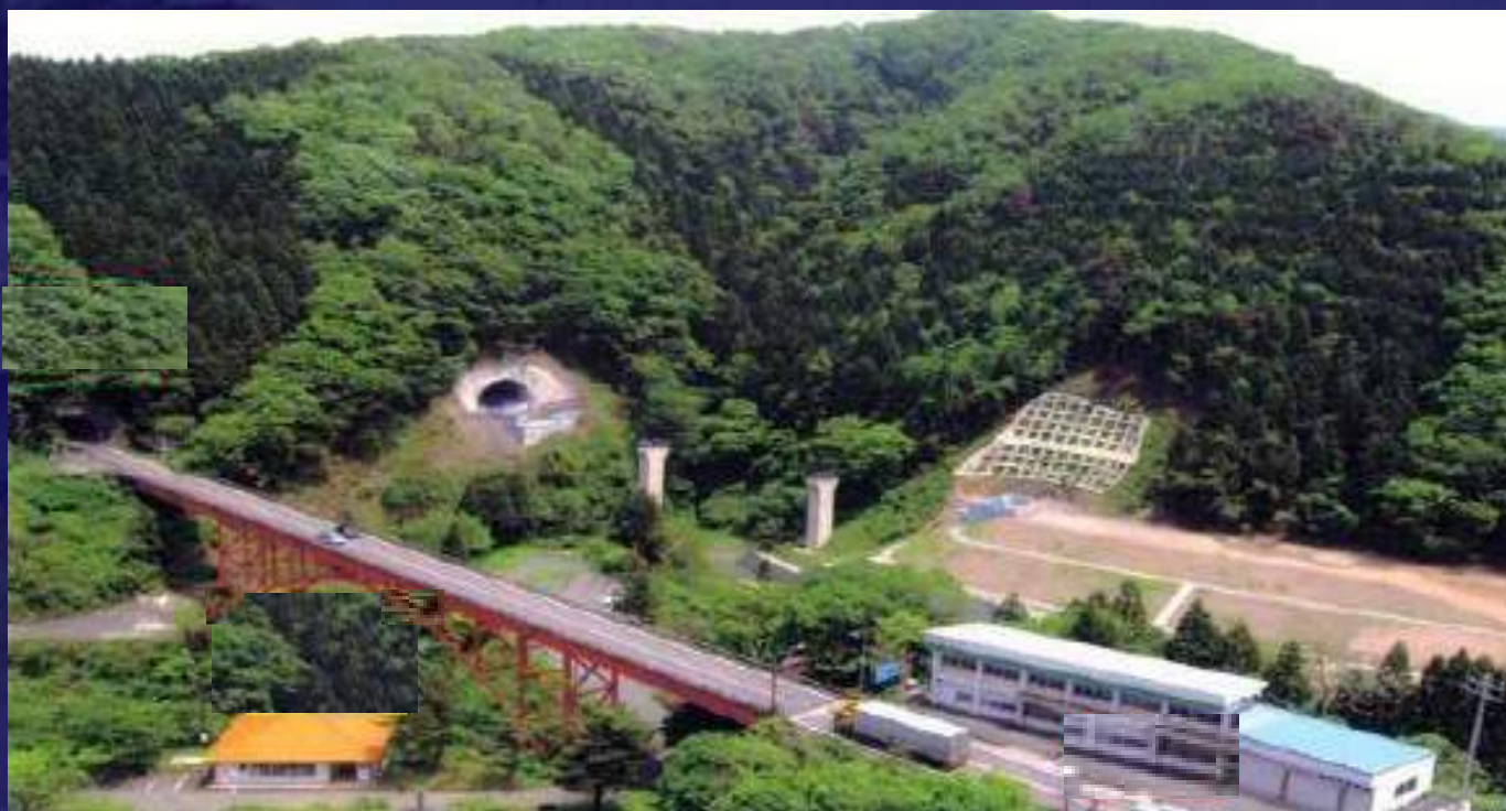
写真-2 国道橋(S橋)S38竣工 大型車混入率45%
