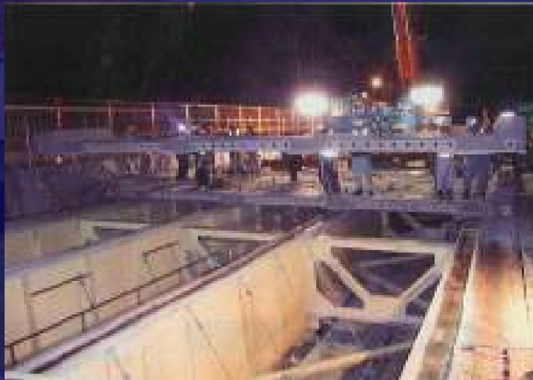
写真-1 プレキャスト床版による全面取替え工法による工事 17
