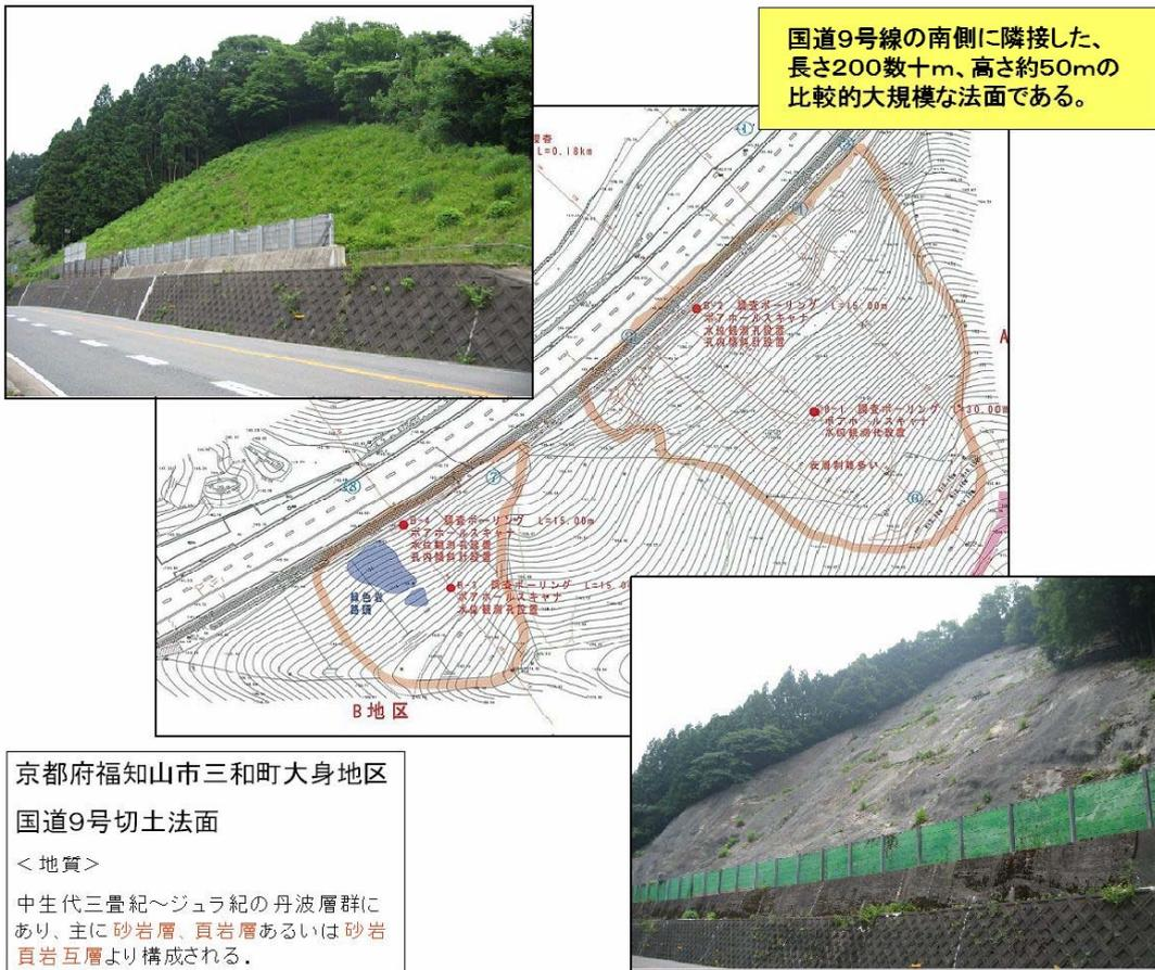
国道9号線の南側に隣接した、長さ200数十m、高さ約50mの比較的大規模な法面である。
