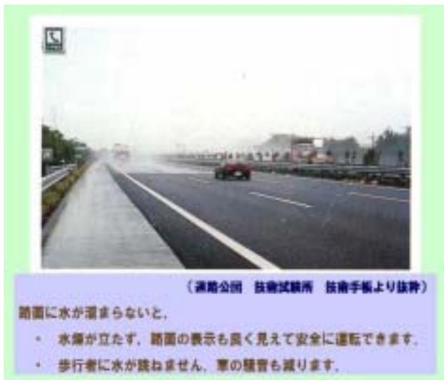
図 - 3 排水性舗装を採用した降雨時の道路
