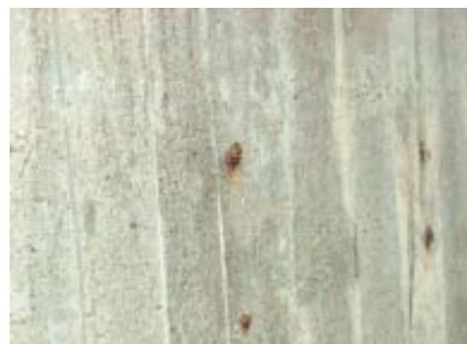
図 9.7 セパレータの腐食
