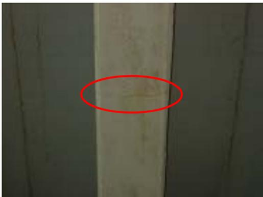
図 9.4 表面塗膜のひび割れの一例
