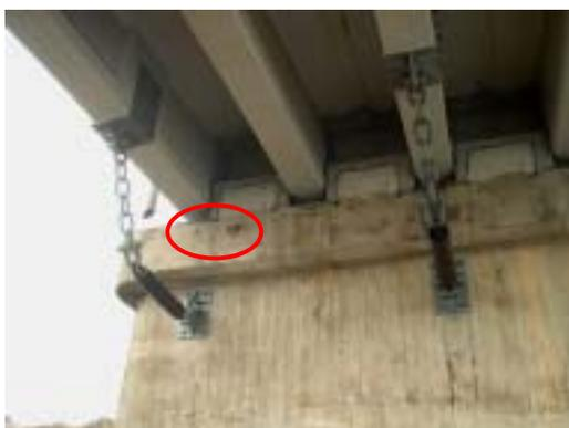
図 9.6 剥離・鉄筋露出の一例
