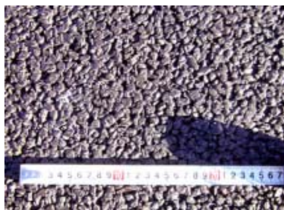
写真 1-1 排水性舗装路面の状況
