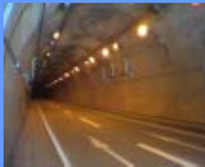
第一トンネル
