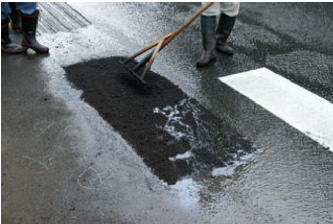
写真-5 散水車による模擬散水状況
