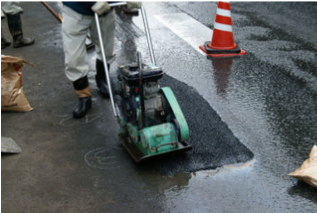
写真-4 常温アスファルト混合物の転圧状況
