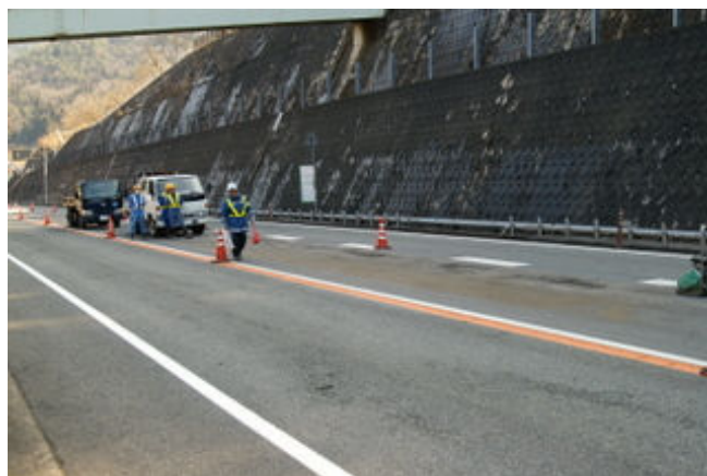
写真-1 模擬ポットホールの全景
