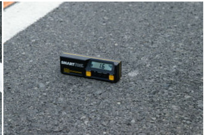
写真-7 道路勾配の測定
