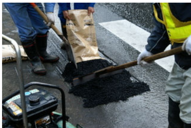
写真-3 常温アスファルト混合物の敷均状況
