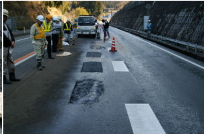
写真-6 常温アスファルト混合物による補修全景
