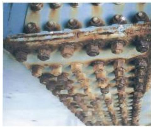
写真 3-2.2 現場継手部の腐食<sup>1)</sup>
