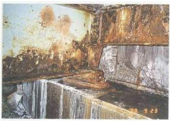
写真 3-2.1 桁端部における腐食<sup>1)</sup>
