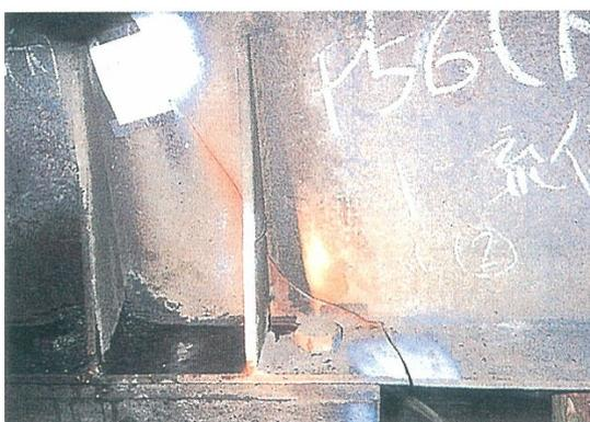
写真 3-2.3 支承ソールプレート溶接部
