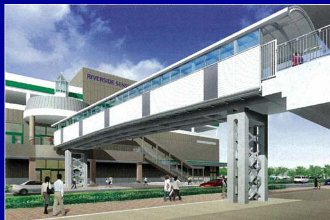
超高強度繊維補強コンクリート「サクセム®」 制震橋脚「ハイレッド橋脚工法」
