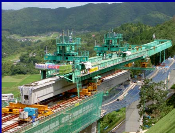
第二戸奈瀬高架橋
