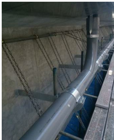
図 6.3.2.1 新設時の設置状況
