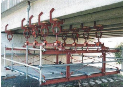
簡易移動足場 (主桁下フランジに固定)
