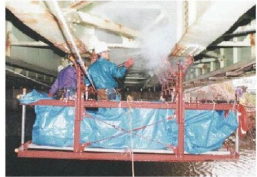
簡易移動足場を用いた洗浄状況
