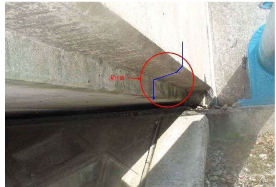
図 5.3.2.6 プレテン床版橋の地覆下部の水切り (主桁への漏水後が見られる)
