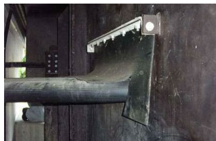
図 4.3.1.3 止水ゴム対策事例 (対策 4-22)
