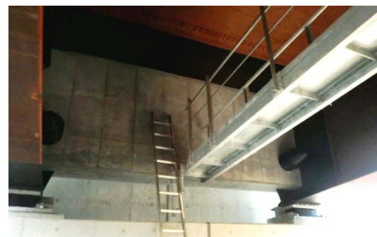
コンクリート巻立て構造の例
