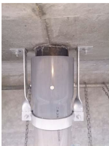
図 6. 3. 1. 4 新設時の設置状況
