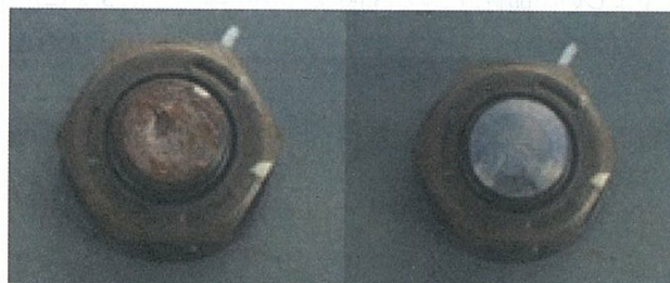
図 4.3.3.2 ピンテール跡仕上げ事例 (対策 4-32)
