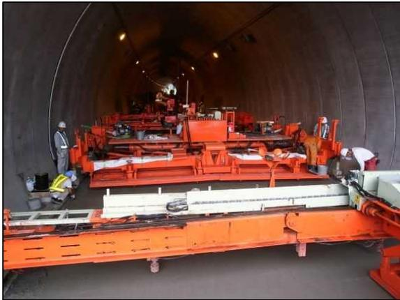
写真-3-11.1 トンネル内のコンクリート版の施工状況
