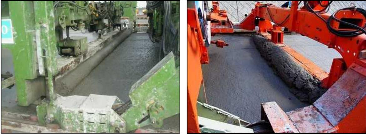
写真-3.6.8 フィニッシングスクリードのモルタルロール（左；適量，右；抱えすぎ）
