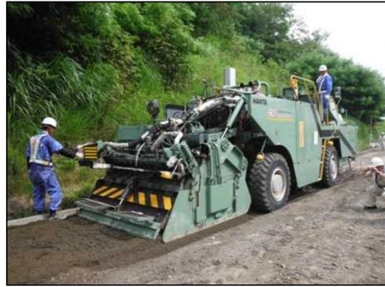
写真-2.3.1 施工機械（左；成形機械 [モーターグレーダ]，右；路上混合器 [スタビライザ]）
