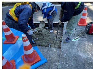
3) 連続鉄筋コンクリート舗装の局部打換え
