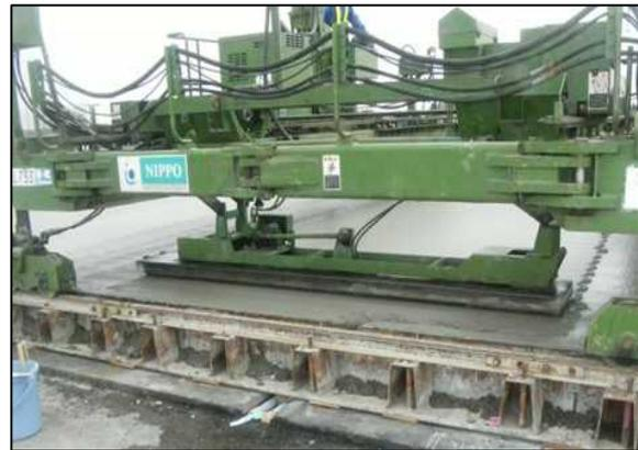
写真-3.6.10 縦型平たん仕上げ機械の例
