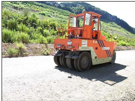
写真-2.5.2 路盤材の締め固め
