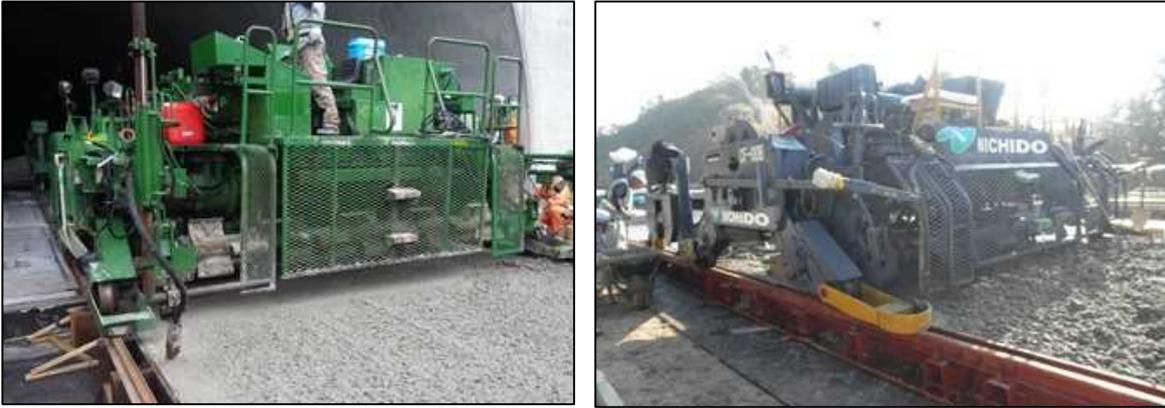
写真-3.6.7 コンクリートフィニッシャの例
