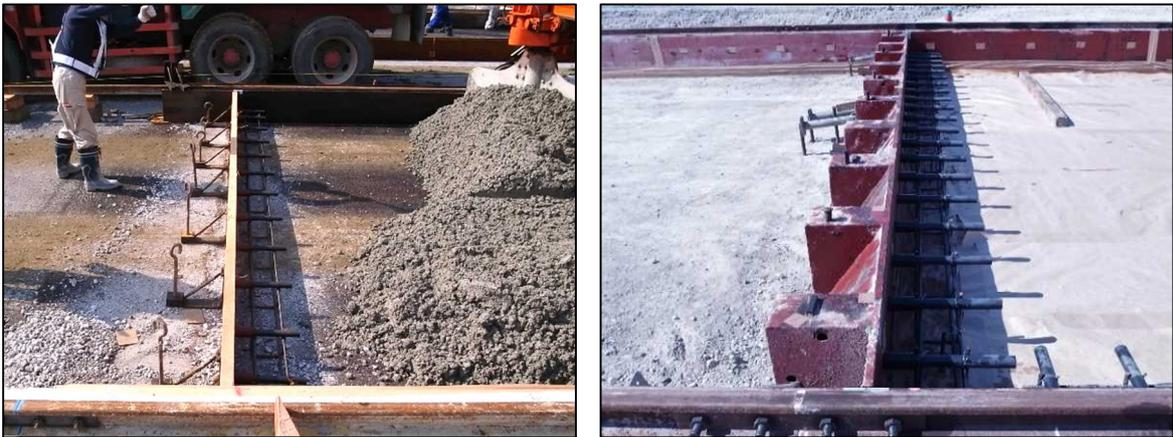
写真-3.4.8 止め型枠設置状況（左；止め板設置，右；鋼製型枠設置）
