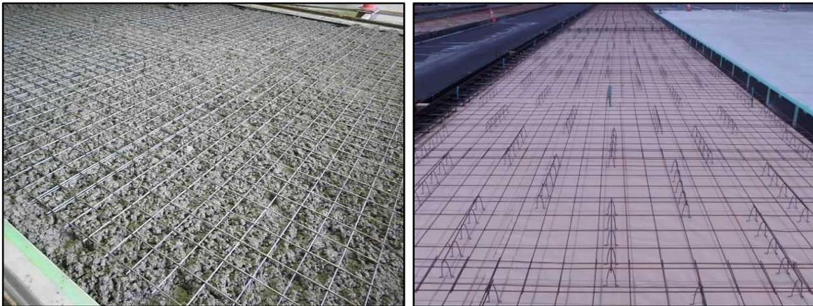
写真-3.6.5 鉄網設置状況
