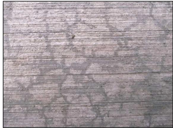
写真-3.10.3 網目状のひび割れ
