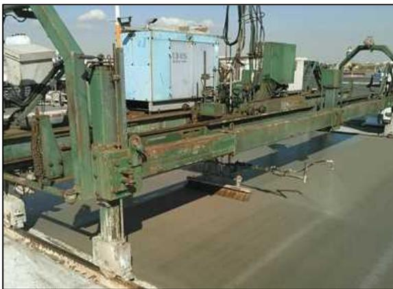
写真-3.6.14 粗面仕上げ（機械）
