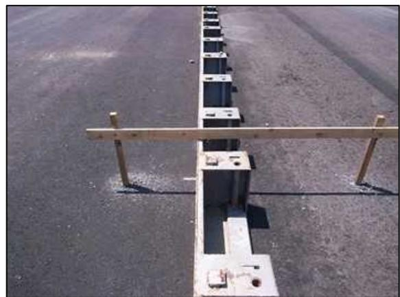
写真-3.2.8 型枠据付のための丁張の例
