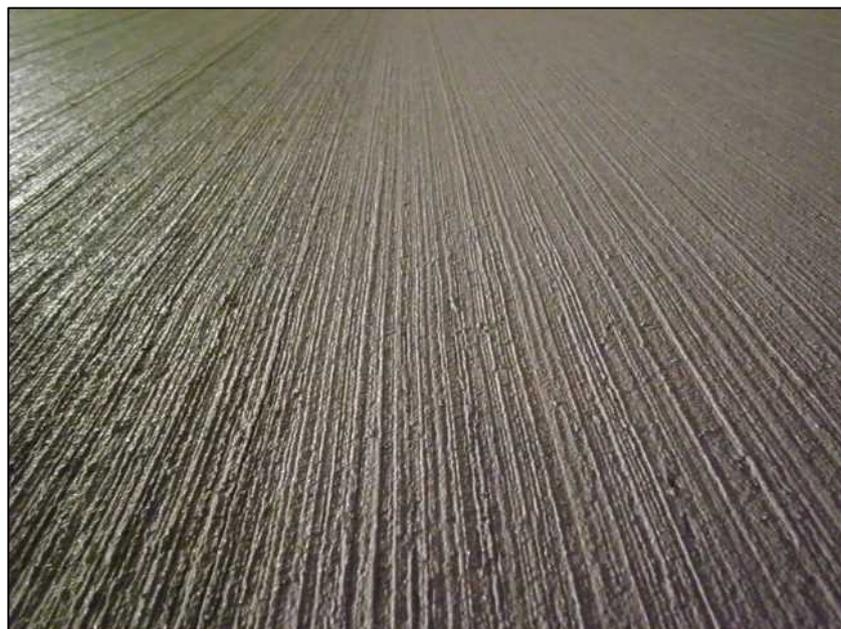
写真-3.6.16 良好な粗面仕上げ状況
