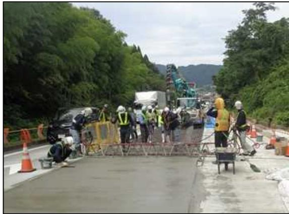
写真-3.8.5 コンクリートポンプによる荷おろし
