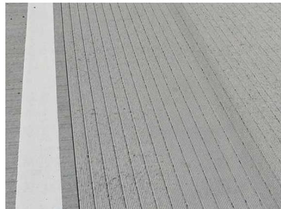
写真-3.6.20 ダイヤモンドグライディング工法の路面
