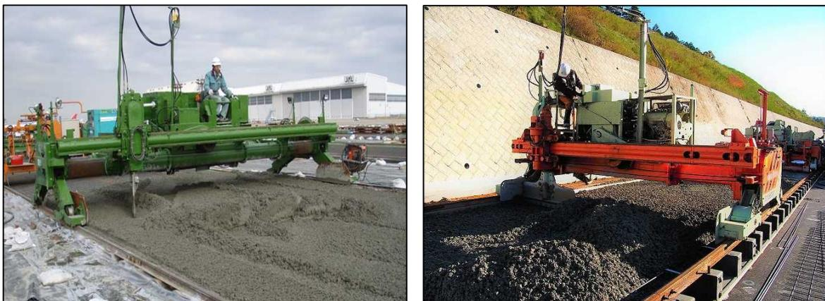
写真-3.6.4 ブレード型スプレッダによる敷きならしの例
