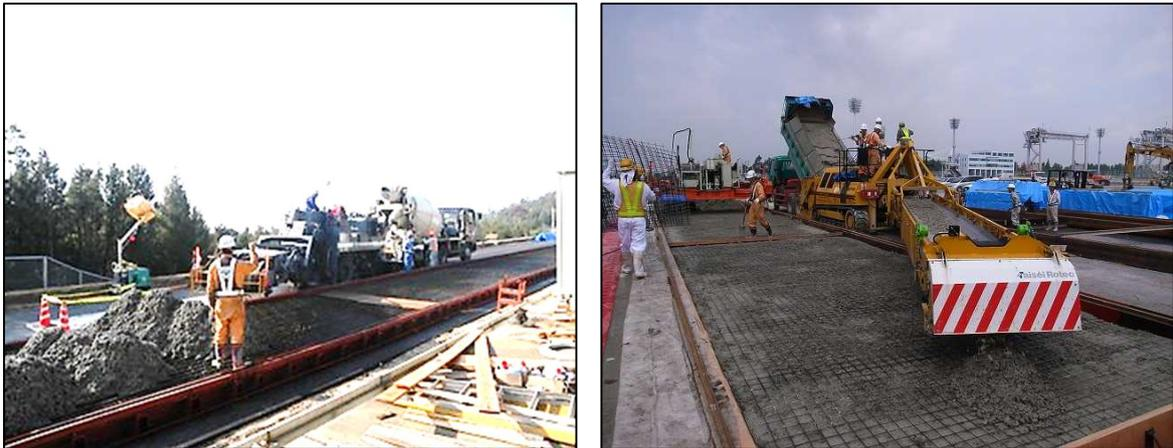
写真-3.6.2 荷おろし機械の例（横取り型）
