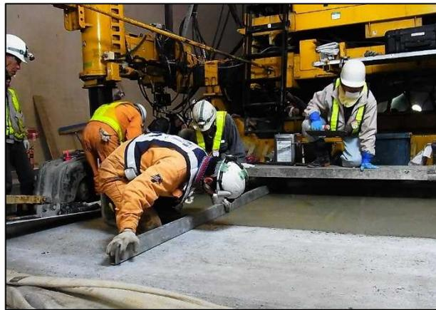
写真-3.7.11 ストレートエッジを用いた起終点部の凹凸確認
