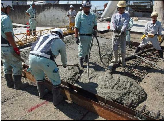
写真-3.11.5 締固め
