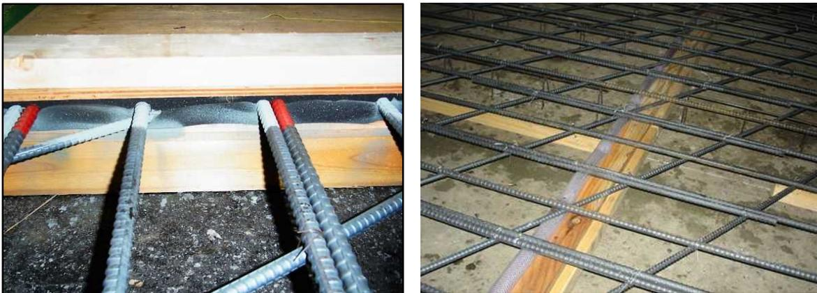
写真-3.7.12 止め型枠の設置例
