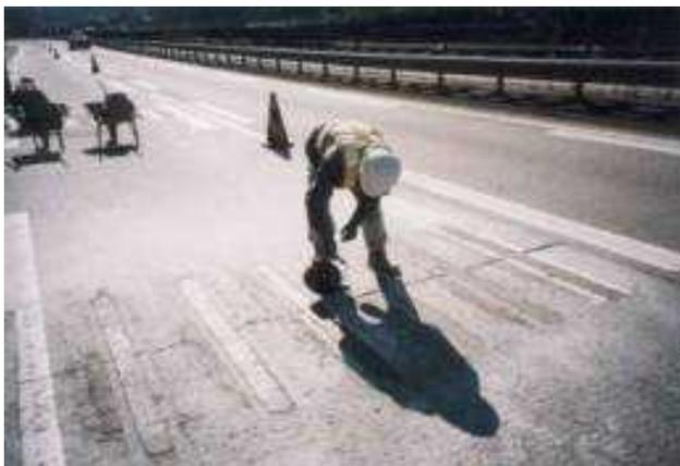
2) 平鋼を用いたバーステッチ（ひび割れや縦目地を緊結する場合）<sup>6)</sup>
