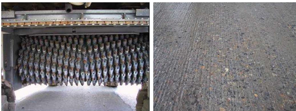
**図-3.9.4 ファインミリングドラム（左）と 適用後の路面（右）**
