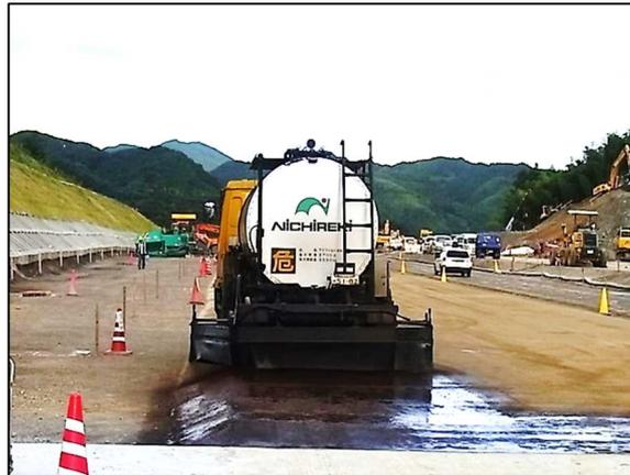
写真-2.7.1 プライムコート施工状況
