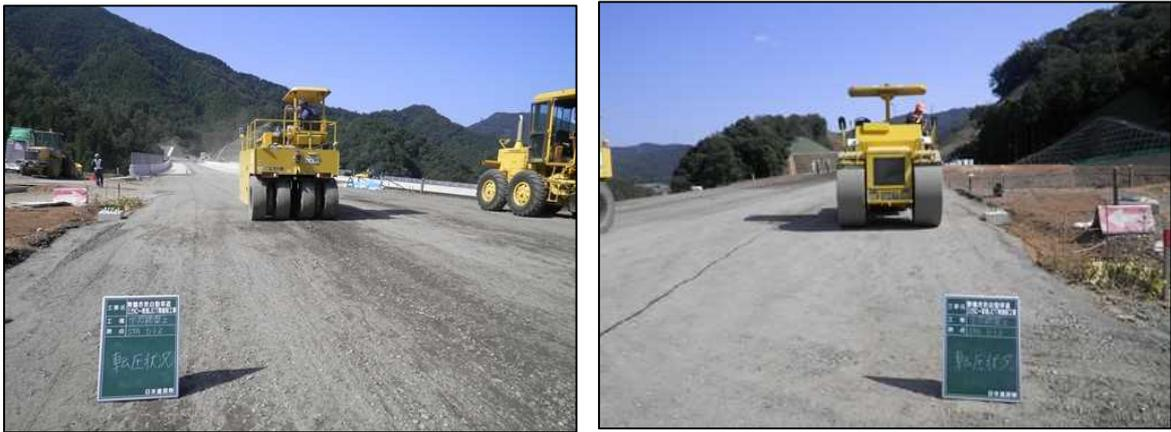
写真-2.3.3 締固め機械（左；タイヤローラ，右；マカダムローラ）
