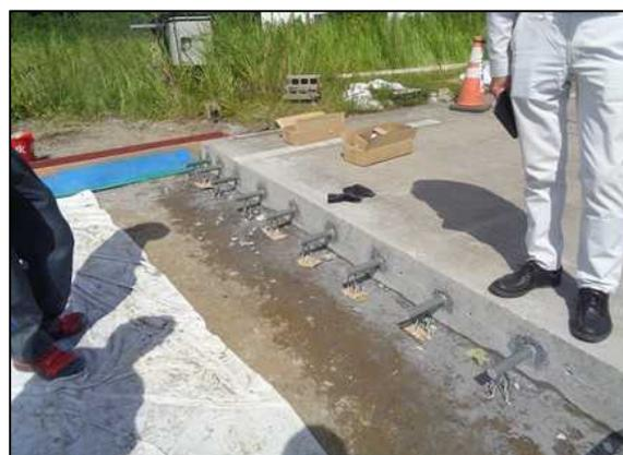
写真-3.4.12 既設コンクリート版へのダウエルバーの設置
