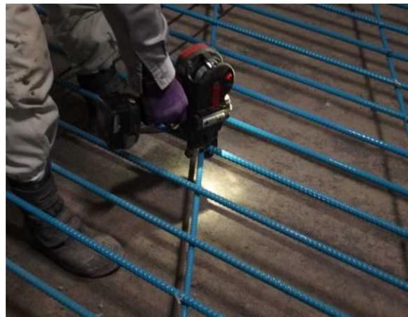
写真-3-3.4 鉄筋結束機による結束
