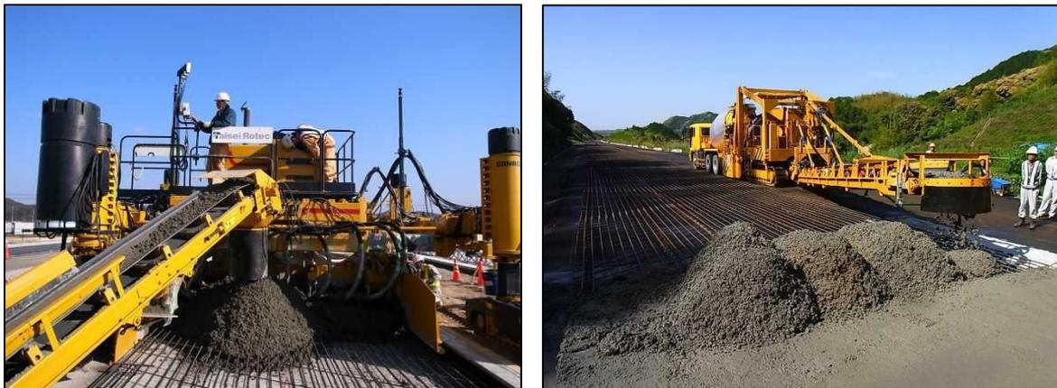
写真-3.7.4 荷おろし状況（左；ペーバ付属の荷おろし装置，右；横取り機）
