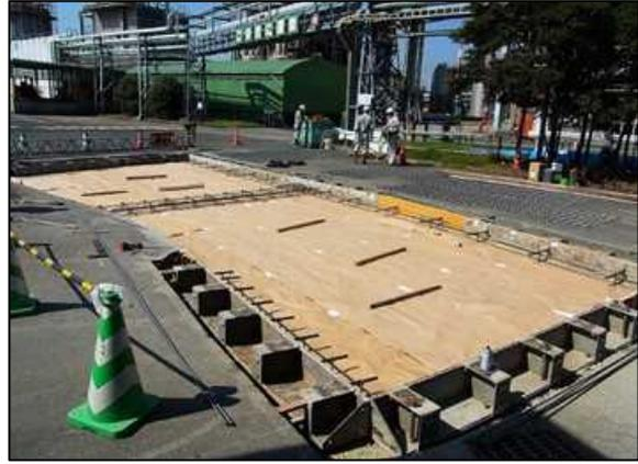
写真-3.2.1 コンクリート舗装用鋼製型枠
