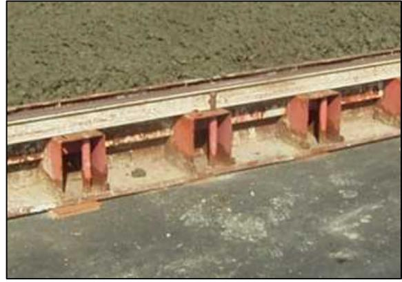
写真-3.2.9 型枠設置の例
