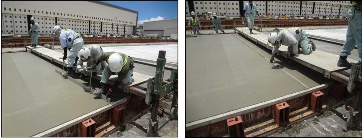
写真-3.4.7 人力による打込み目地の施工例
