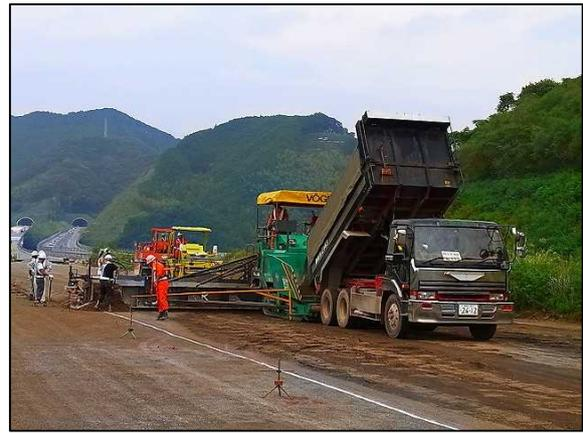
写真-2.5.1 ベースペーパーを用いた路盤材の敷きならし
