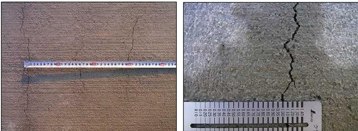
写真-3.10.4 沈下ひび割れ(左;150mm 間隔で発生, 右;ひび割れ幅 1.0mm)
