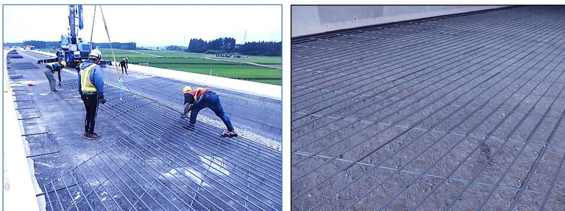
写真-3.3.5 プレハブ鉄筋の例
