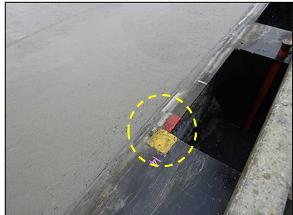
写真-3.2.10 カッタ切断位置の明示例
