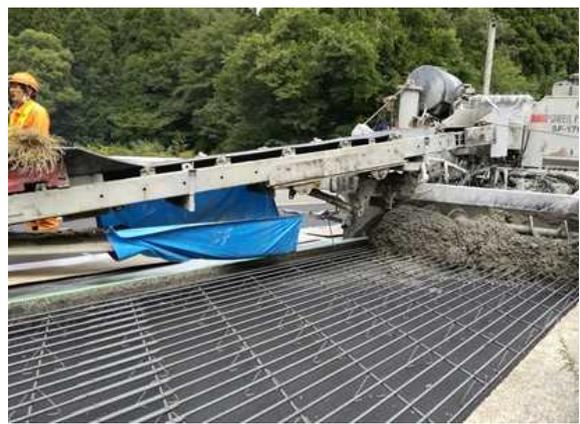
写真-3.2.5 アスファルト舗装を型枠代わりに使用した事例
