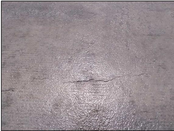
写真-3.10.2 プラスチック収縮ひび割れ
