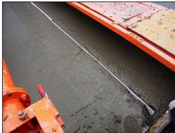
写真-3.4.6 打込み目地施工状況
