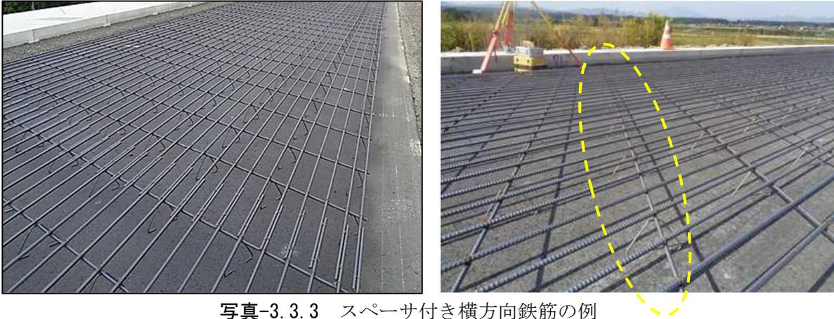
写真-3.3.3 スペーサ付き横方向鉄筋の例
