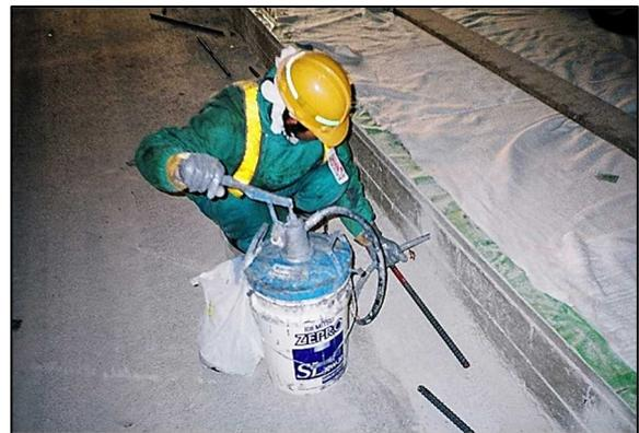
写真-3.7.10 穿孔方式によるタイバー設置状況
