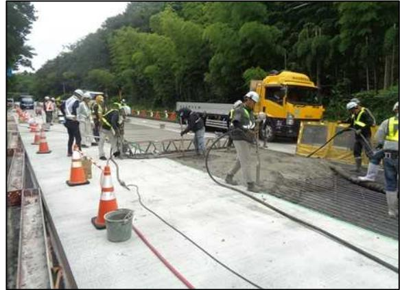
写真-3.8.7 締め固め状況
