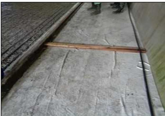
写真-3.2.12 レールずれ止めの例
