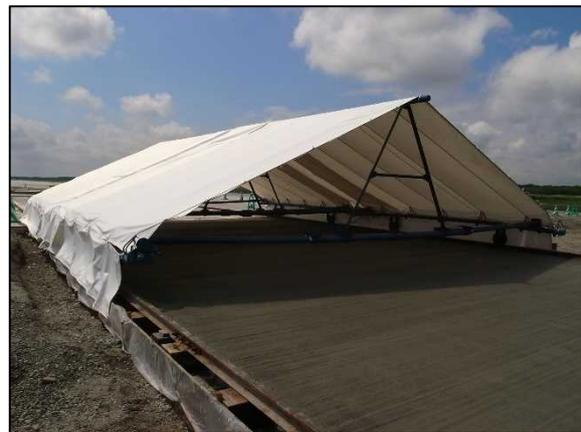
写真-3.9.5 初期養生（左；養生剤散布，右；三角屋根養生
