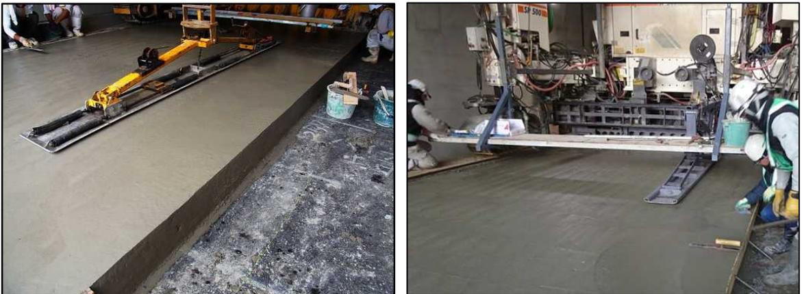
写真-3.7.14 ペーパーに取り付けられた縦仕上げ装置の例
