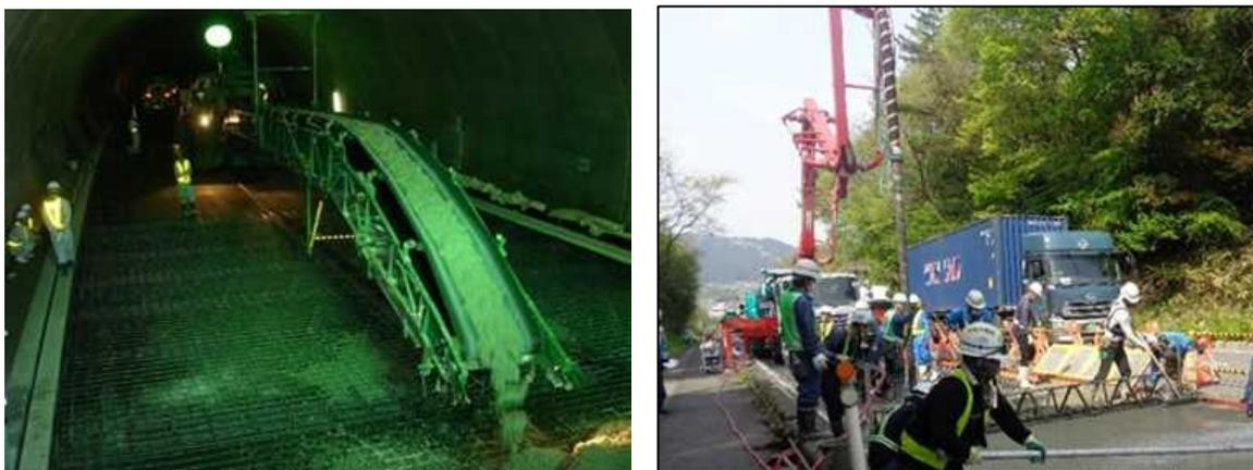
写真-3.6.3 荷おろし機械の例（縦取り型）
