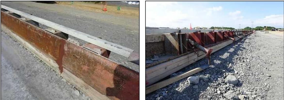
写真-3.2.6 型枠の高さ調整（下面に木材設置）
