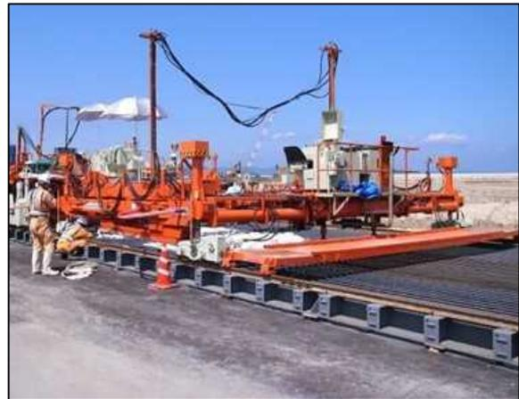
写真-3.6.1 ブレード型スプレッタによる敷きならし
