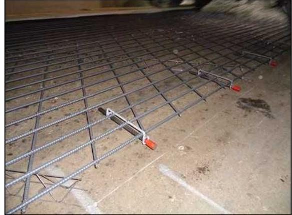
写真-3.7.9 タイバー固定治具によるタイバー設置
