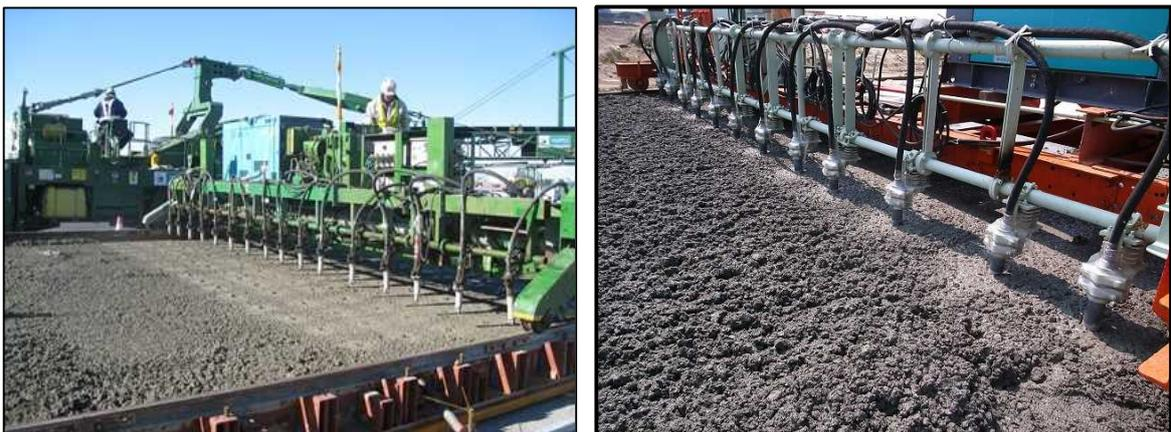
写真-3.6.9 垂直挿入式の内部振動機
