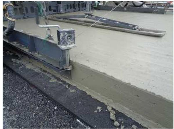
写真-3.7.7 モールドから押し出された状態（左：ゴメコ社，右：ビルトゲン社）
