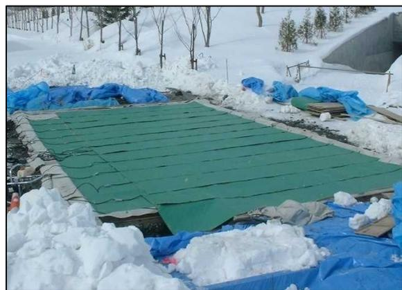
写真-3.9.4 給熱養生例（左；ジェットヒータ，右；電熱マット）
