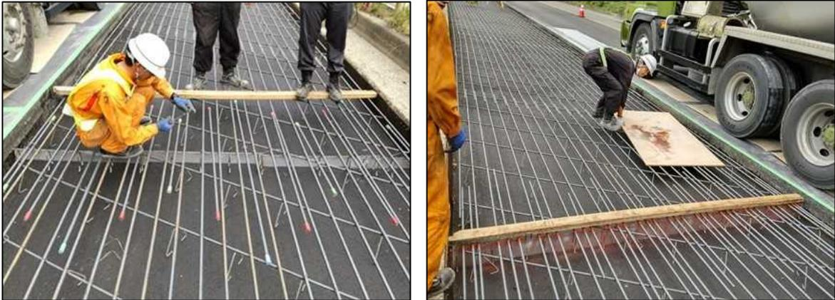
写真-3.7.13 ラス型枠による止め型枠の設置例
