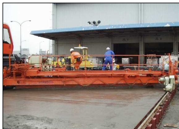
写真-3.6.11 斜め型平たん仕上げ機械の例
