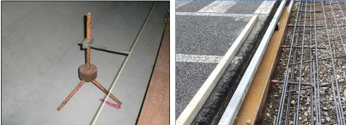
写真-3.7.2 センサによる高さ制御（左：センサライン，右：角パイプ）
