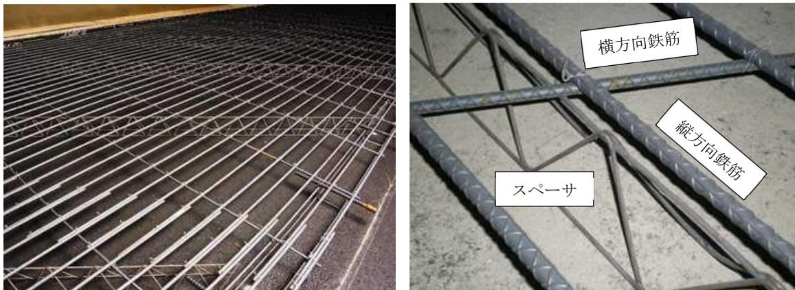
写真-3.3.1 鉄筋類の設置
