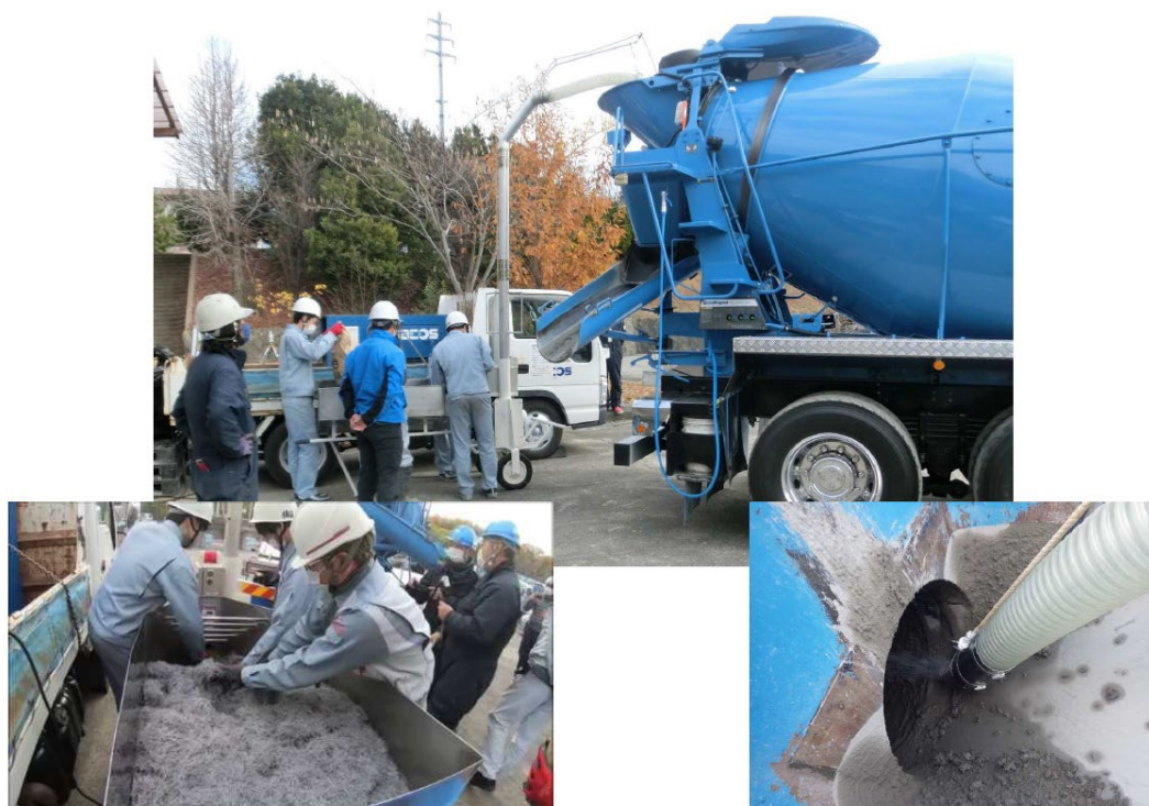
写真 2.1 繊維投入状況
