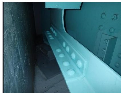
写真3.6 端対傾構の特殊な構造事例
