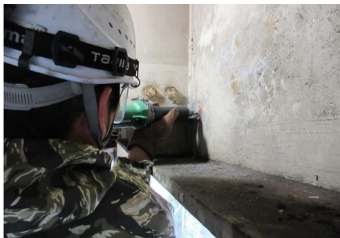
写真6.1バーグラインダーによる削り込み
