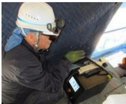
(1) ポータブル型レーザーケレン装置
