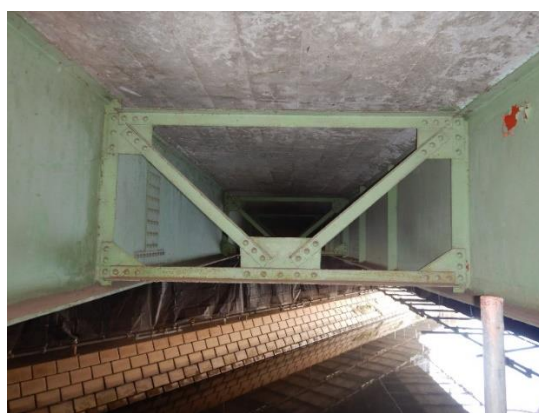
写真3.5 リベット対傾構 (図 3.6 タイプ)
