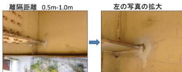
(3) ドローンによる撮影の事例（主桁・横桁部取合い部）
