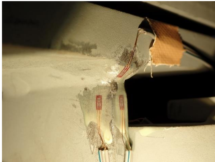
(c) ひずみゲージ設置状況（载荷反対側）
