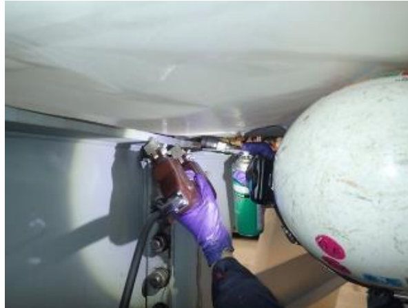
図5.9 垂直補剛材上端部溶接部の磁化（磁力線とき裂が出来るだけ直角に）
