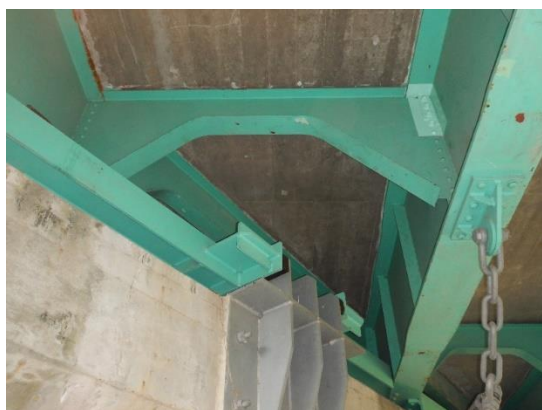
写真3.3 ニーブレース曲げフランジ構造
