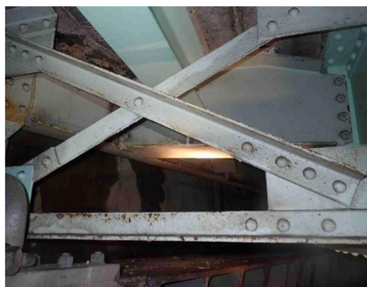
写真3.4 リベット対傾構 (図 3.10 タイプ)
