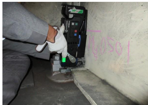
写真6.2小型の穿孔機による穿孔
