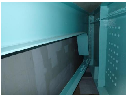
写真3.6 端対傾構の特殊な構造事例
