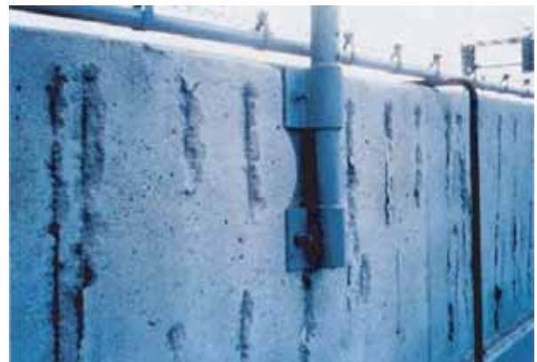
写真 2.1.1(4)-1 道路橋壁高欄の事例
