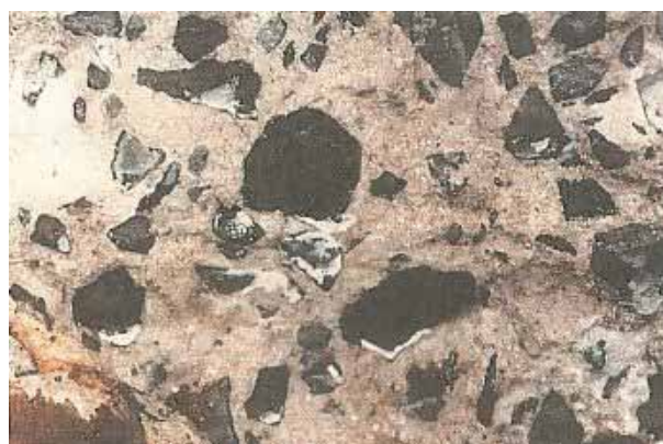
写真 2.1.1(2)-1 アルカリシリカゲルの生成状況
