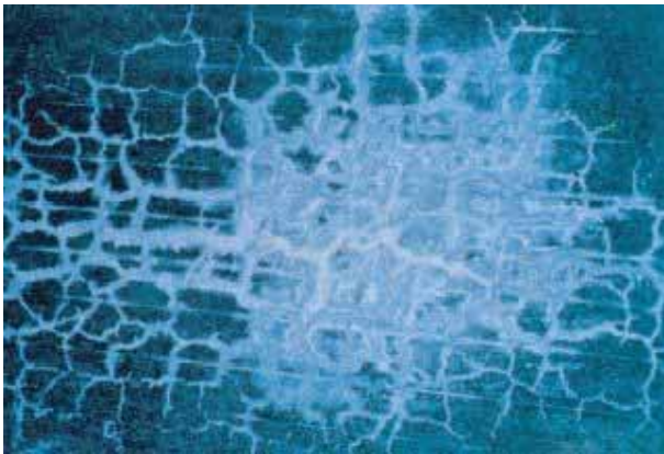
(c) ひび割れの網細化
