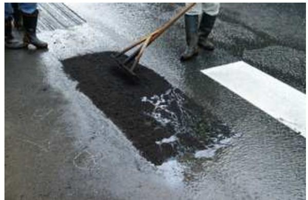
写真-5 散水車による模擬散水状況
