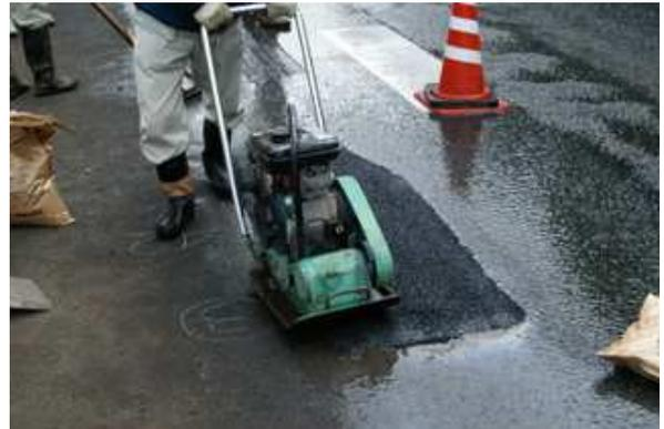
写真-4 常温アスファルト混合物の転圧状況
