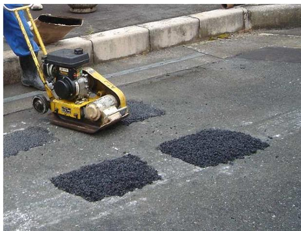
写真-9 プレートによる締固め
