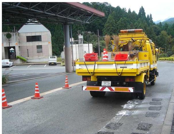
写真-8 作業車による締固め
