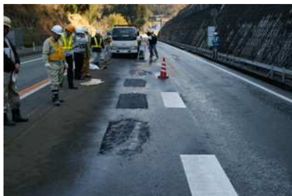
写真-6 常温アスファルト混合物による補修全景
