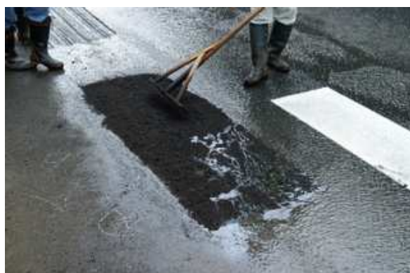
写真-5 散水車による模擬散水状況
