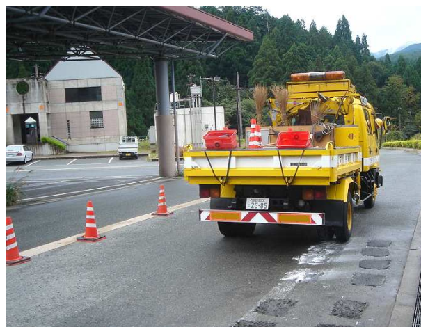
写真-8 作業車による締固め
