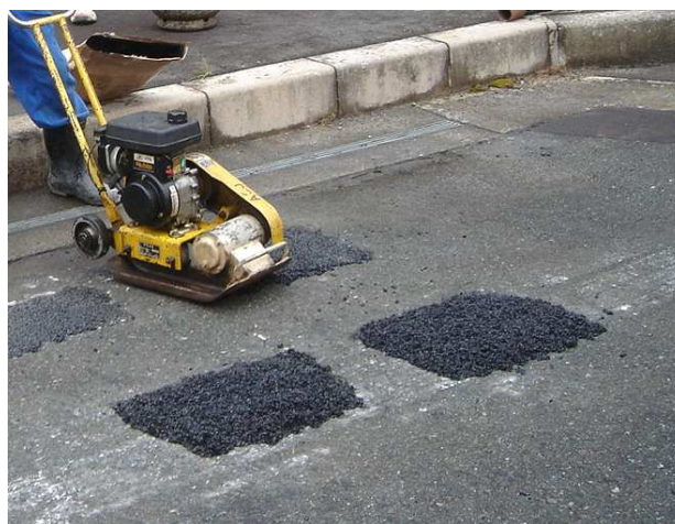
写真-9 プレートによる締固め
