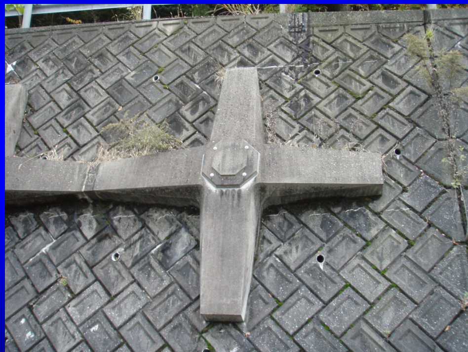
受圧板のコンクリートキャップ
