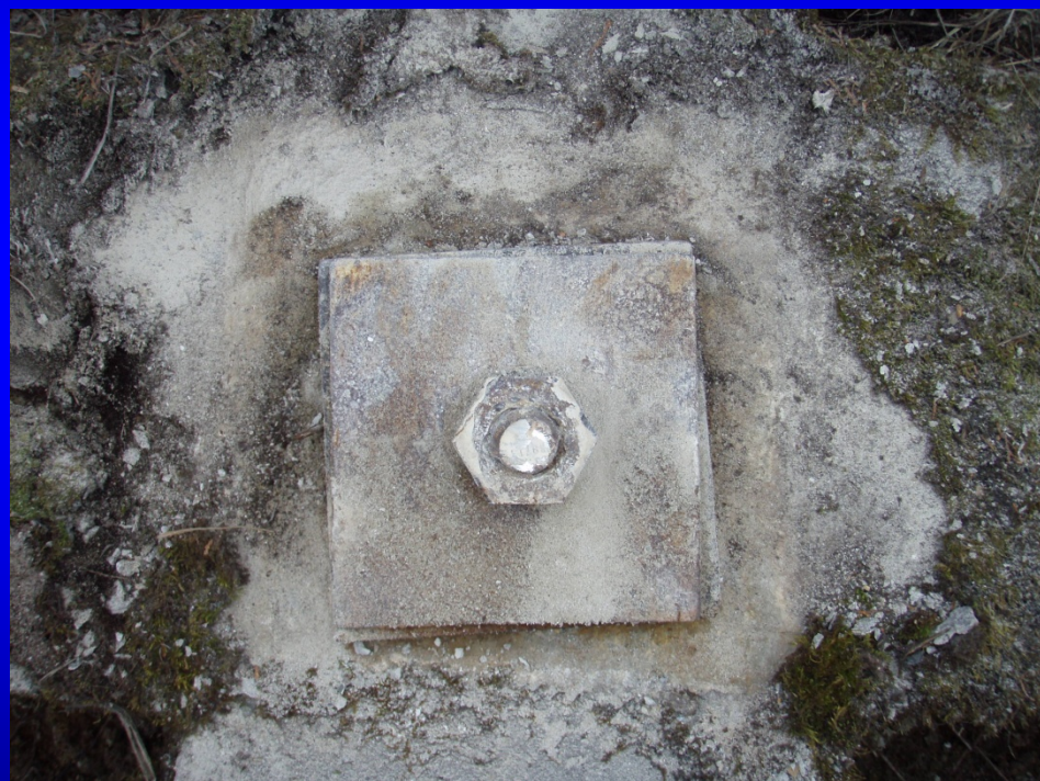
頭部コンクリート除去後
