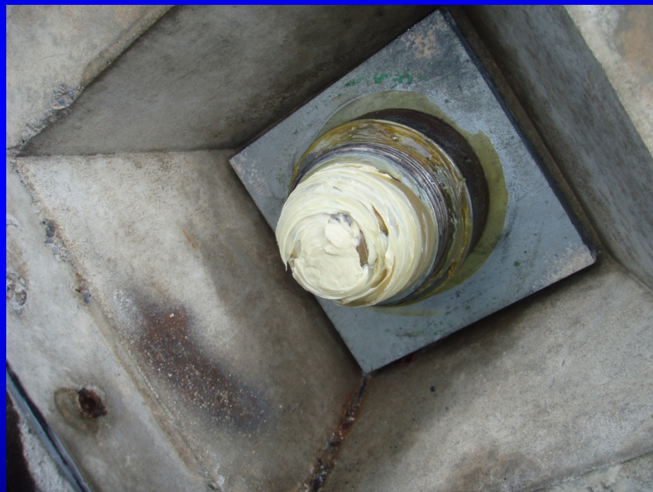
ヘッドキャップ内の防 錆油充填状況
