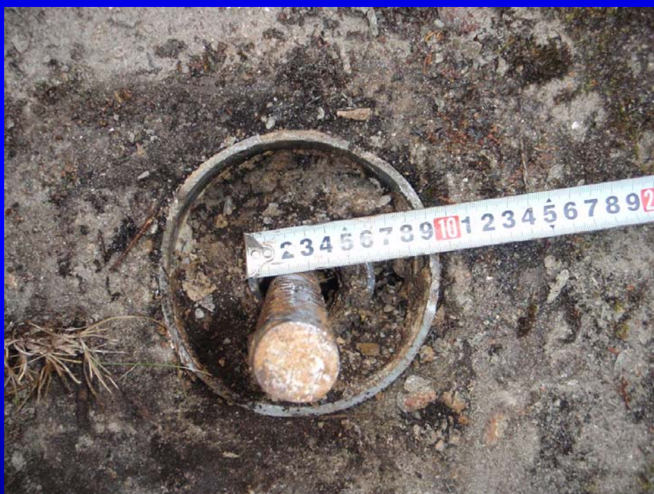
アンカープレート背面
