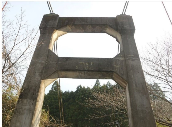
写真 2-2 コンクリート製主塔
