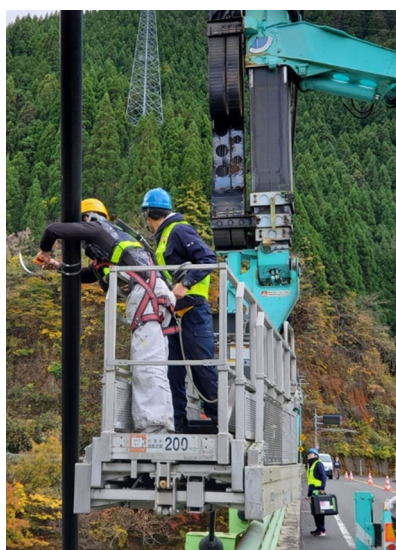
写真 4-4 ケーブルへのセンサ設置作業とセンサ設置状況
