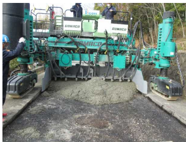
写真-2 施工状況
