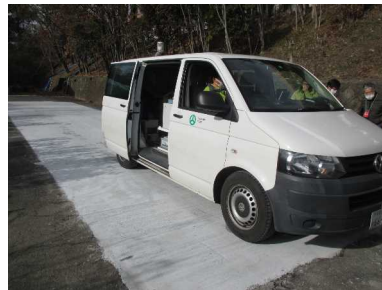
写真-3 FWD 載荷試験
