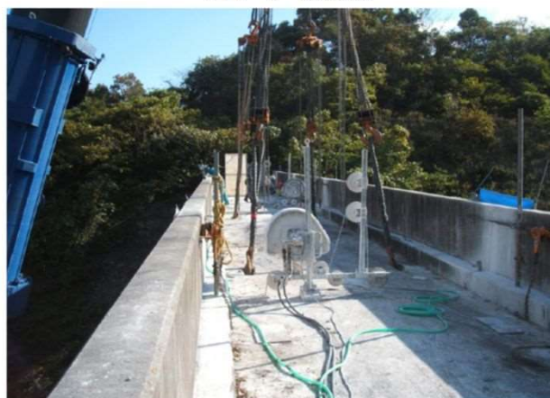
ワイヤーソー切断状況
