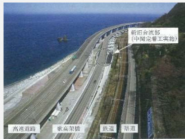
写真 - 7 歌高架橋 (中央、終点側より)
