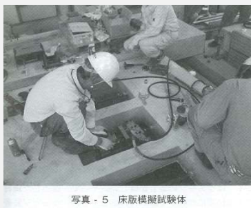
写真 - 5 床版模擬試験体
