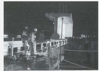
写真 - 15 主桁撤去
