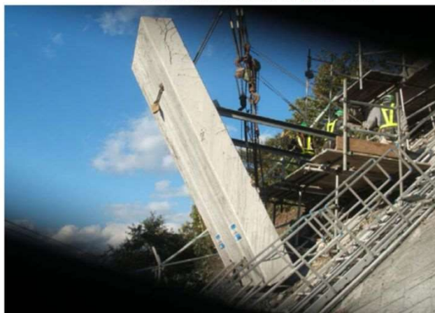
斜材転倒防止材設置による斜材撤去状況
