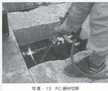
写真 - 13 PC鋼材切断
