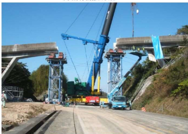
中央部分割撤去状況
