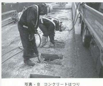
写真 - 8 コンクリートはつり
