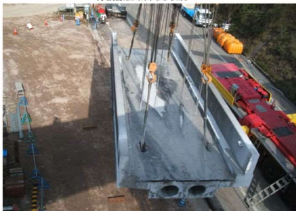
分割撤去吊降ろし状況
