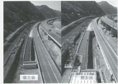
写真 - 16 主桁撤去前後の状況 (始点側より)
