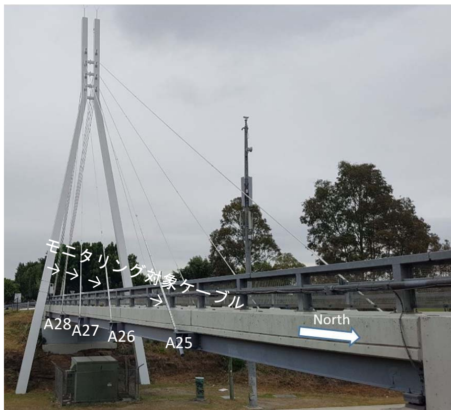
(a) 橋梁の全景
