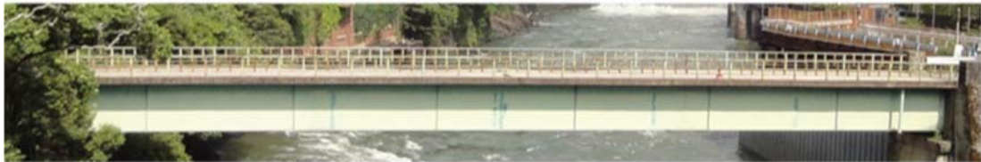
図 5.14 モニタリング対象橋（鋼鈑桁橋）
