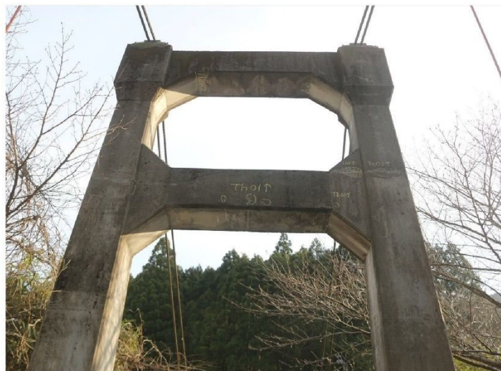
写真 2-2 コンクリート製主塔
