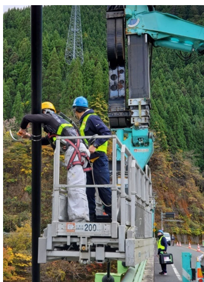
写真 4-4 ケーブルへのセンサ設置作業とセンサ設置状況
