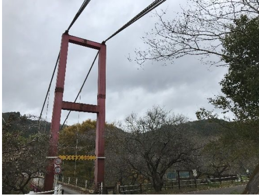
写真 2-3 鋼製主塔
