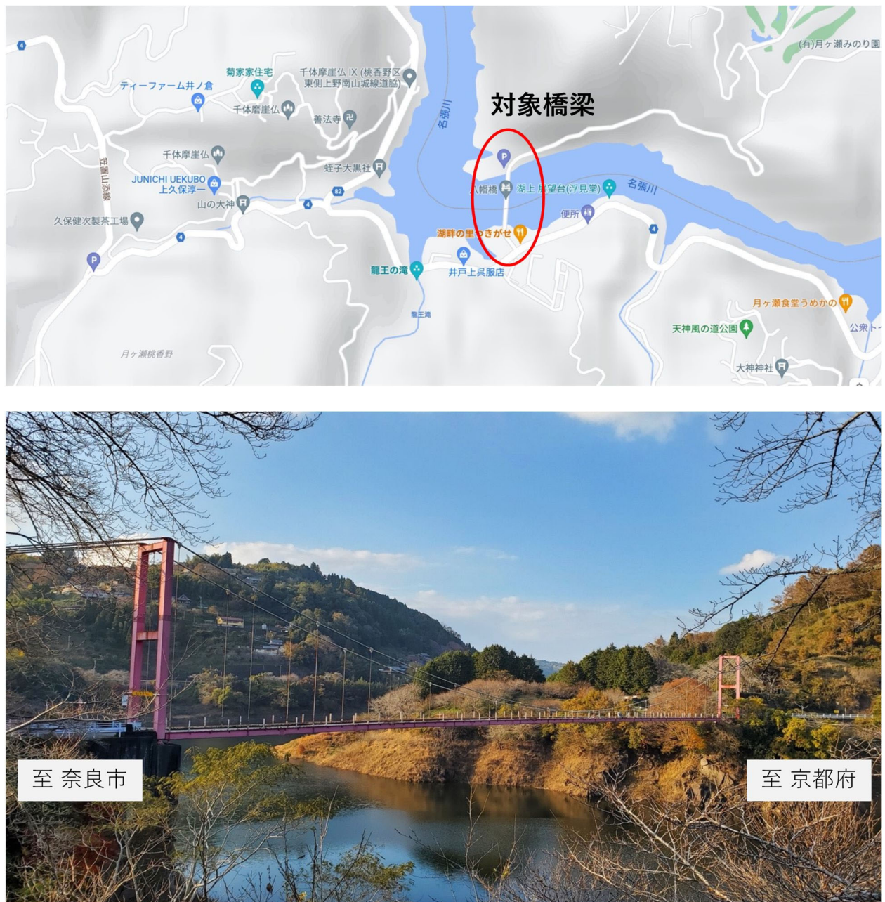
図3-1 モニタリング対象吊り橋の位置と全景
