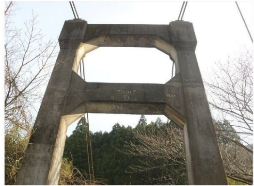
写真 2-4 コンクリート製主塔
