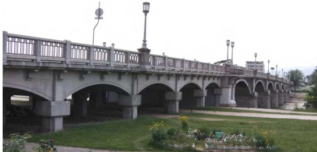
単純RCT桁(6連)+6径間連続RCアーチ橋+単純RCT桁(3連)
