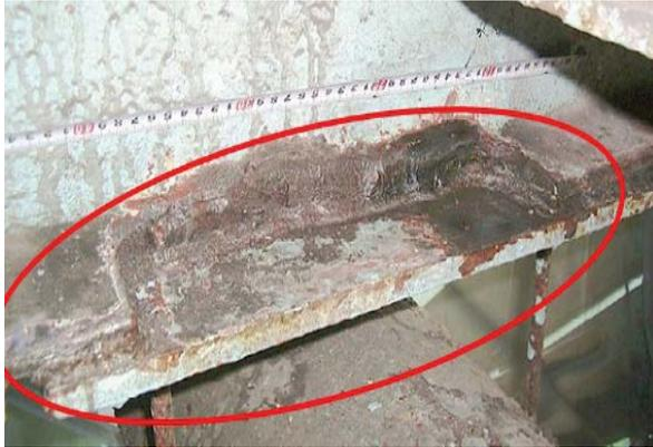
図8 横桁補修箇所の磁粉探傷試験実施箇所
