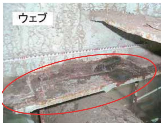
写真 5 横桁補修部の非破壊試験箇所
