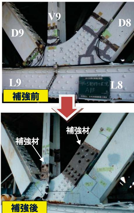
図2 補強の一例 (主構トラス G1 下流側 A 部)
