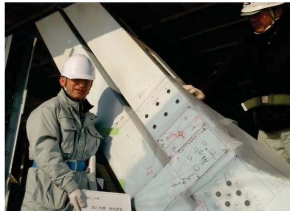
写真4 原寸図による細部確認
