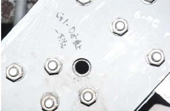
写真5 母材ビード部確認用搾孔
