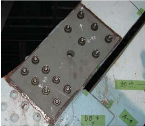
図1-4 補強後のコア採取状況
