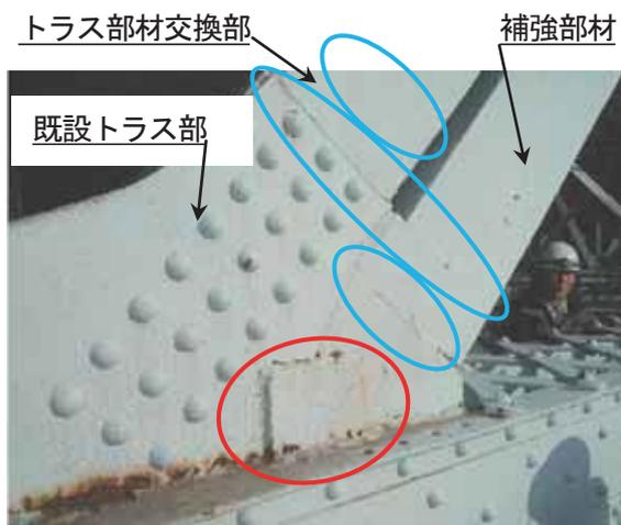
写真 4 トラス斜材補強部の非破壊試験箇所例
