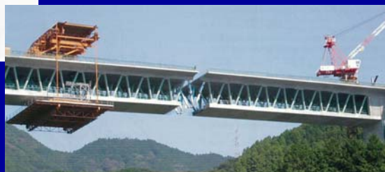
猿田川橋・巴川橋
