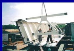
現場でのパネル組立て状況
