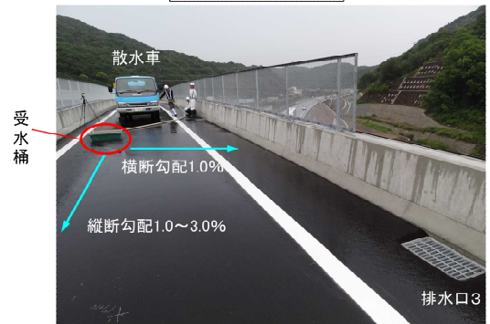
橋面概観(桁端部から)
