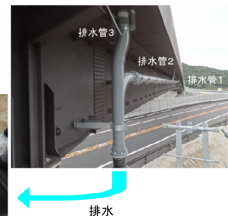
孝子ランプ橋における排水実験の概要
