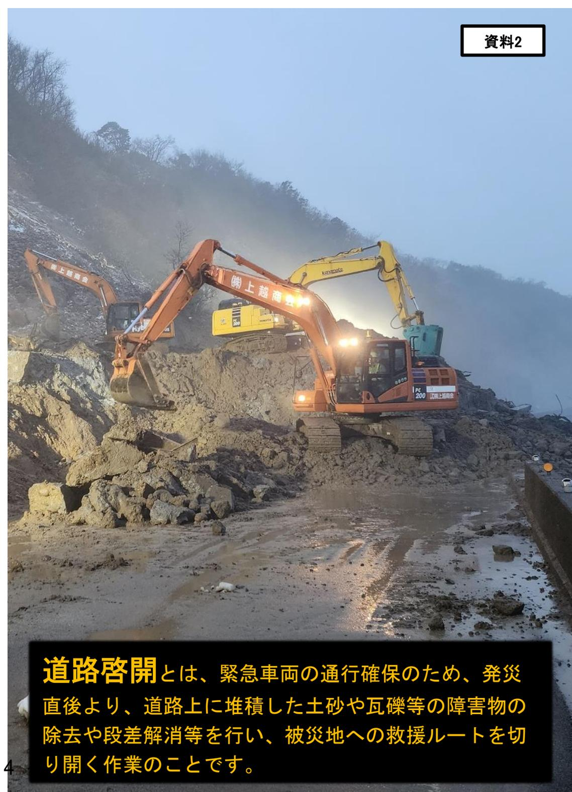
**道路啓開**とは、緊急車両の通行確保のため、発災直後より、道路上に堆積した土砂や瓦礫等の障害物の除去や段差解消等を行い、被災地への救援ルートを切り開く作業のことです。
