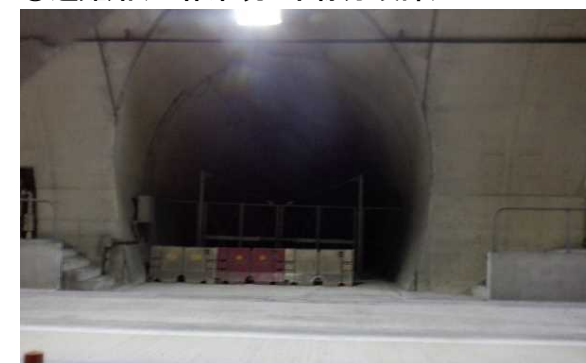
③避難路(旧作業坑 本線分岐部)
