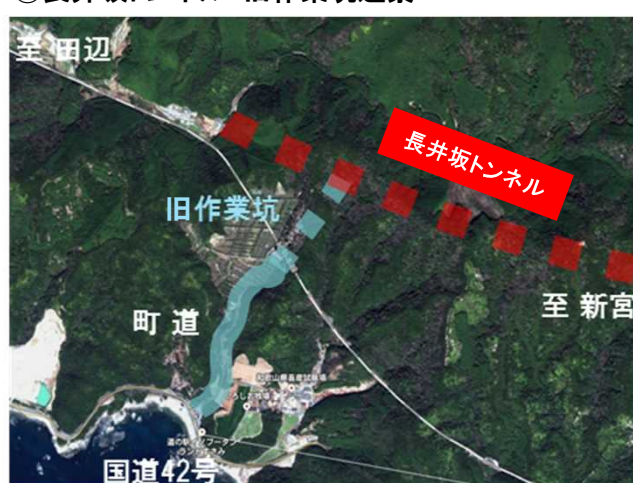
④長井坂トンネル・旧作業坑遠景
