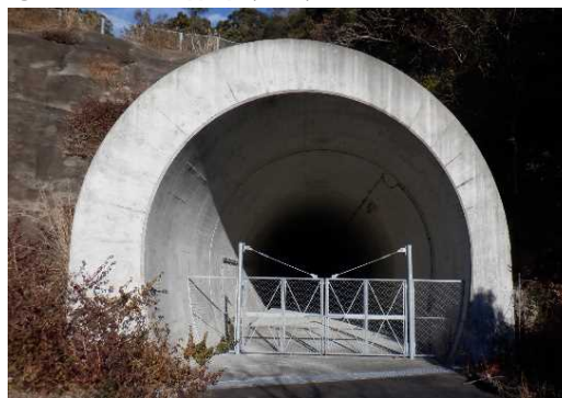
②避難路(旧作業坑 坑口正面)
