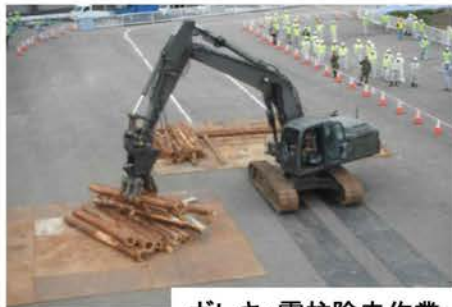
ガレキ・電柱除去作業
