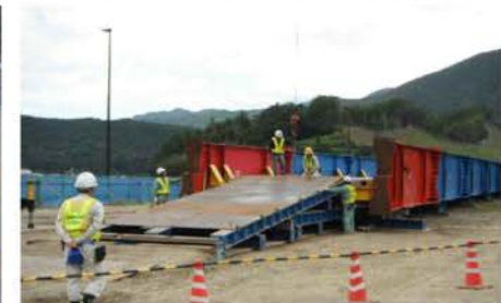
緊急仮設橋スロープ設置状況
