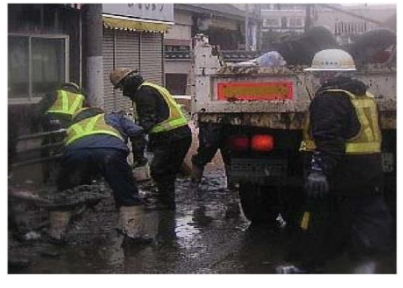
ダンプトラックによる搬出
