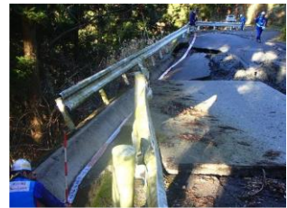
長野県北部地震における調査事例
