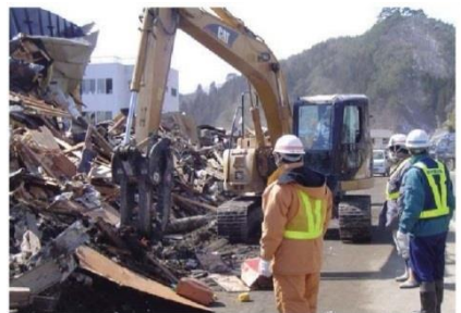
ガレキの撤去作業
