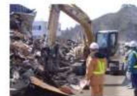
ガレキの撤去作業
