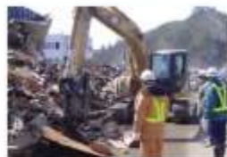
ガレキの撤去作業
