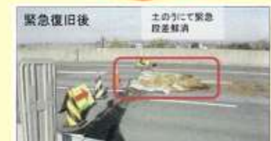
東日本大震災時の緊急復旧状況
