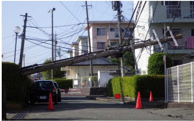
災害時における道路被害の事例
