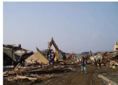
道路脇への山積による車線確保
