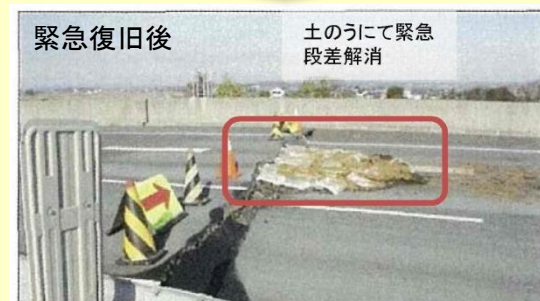
東日本大震災時の緊急復旧状況
