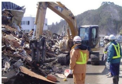
ガレキの撤去作業
