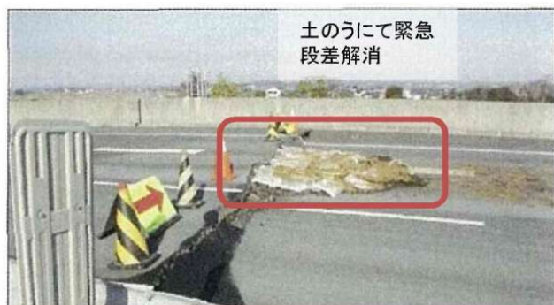
橋梁段差の解消
