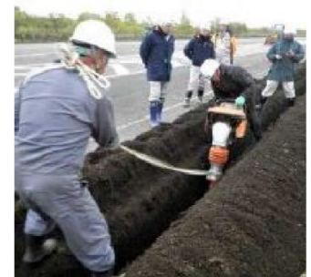
図 ランマによる締固め
