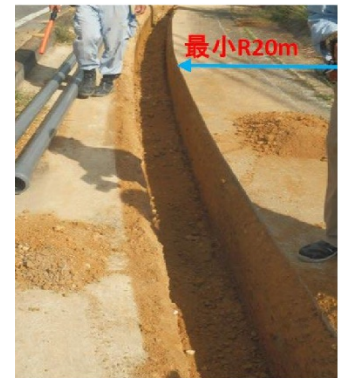
図 曲線施工状況
