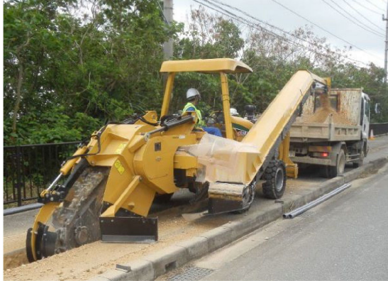
図 トレンチャーの作業形態(掘削＋土砂排出)
