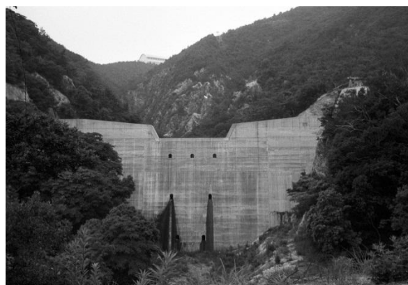
堺川堰堤（昭和17年3月完成）
