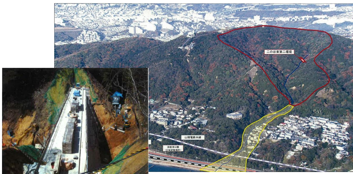
二の谷東第二堰堤（平成26年4月現在）
