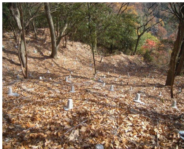
樹木を伐採せずに斜面の安定を図る斜面对策工
