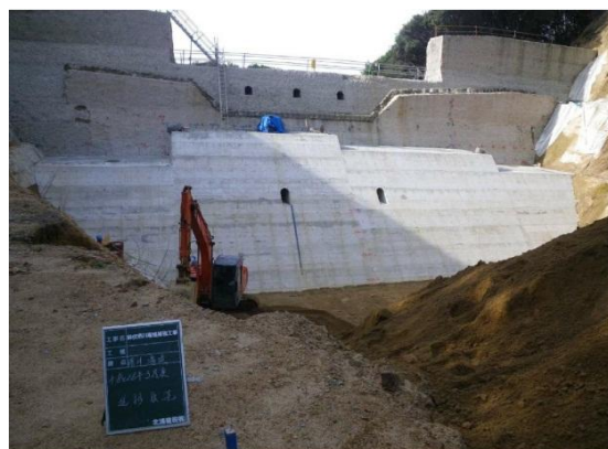
施工中の堺川堰堤（平成26年4月現在）
