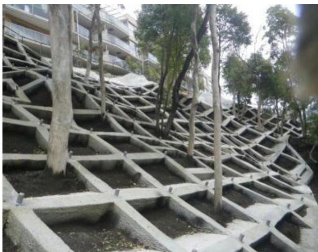
樹木を伐採せずに斜面の安定を図る斜面对策工
