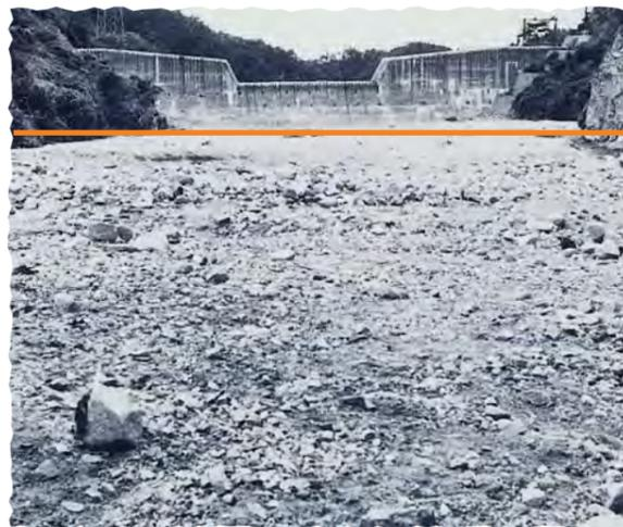
災害後 (12万<sup>3</sup>mの土石流を貯留)
