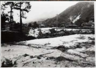
S13 阪神大水害被災状況
