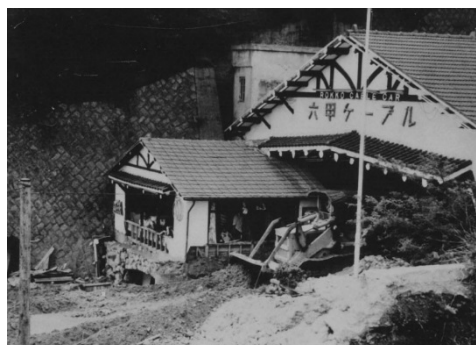
六甲ケーブル下駅から流出した土砂
