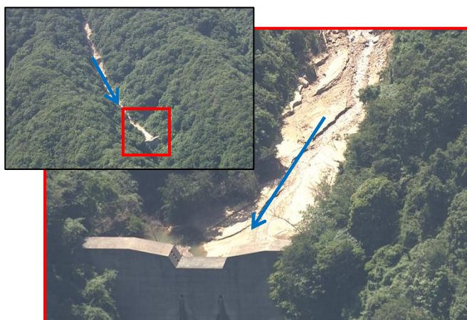
平成30年7月豪雨 土砂補足状況
