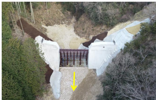
紅葉谷第五堰堤
