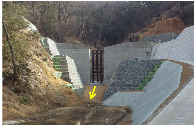
水呑第二堰堤
