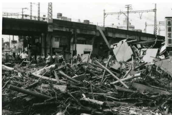
中央区北長狭通8丁目 JR高架下の惨状
