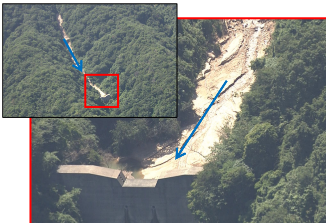
平成30年7月豪雨 土砂補足状況
