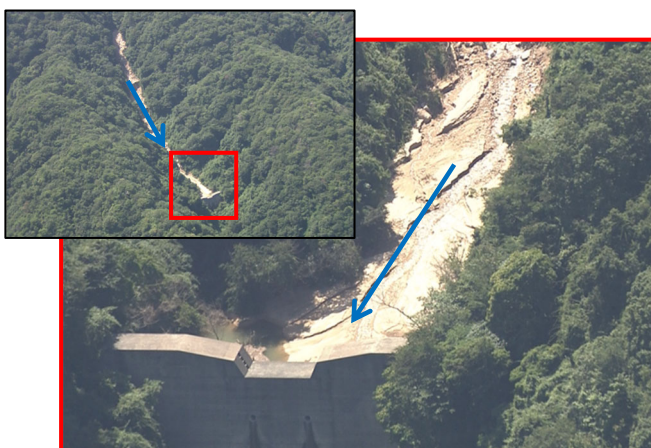
平成30年7月豪雨 土砂捕捉状況
