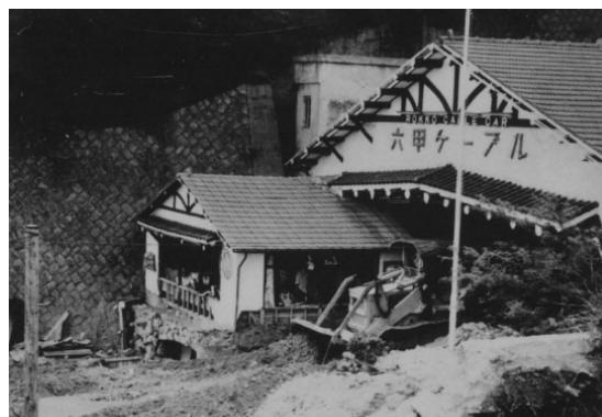
土砂に埋まった六甲ケーブル下駅
