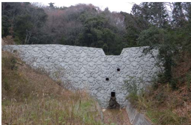
小部中学校に近い砂防えん堤 （妙賀山えん堤（高さ12.5m、長さ50.0m））
