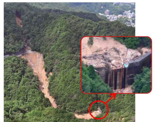
平成26年台風11号による崩壊と 土砂を捕捉した砂防えん堤 (神戸市北区)
