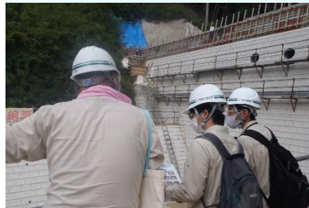
砂防堰堤工事の現場を見学
