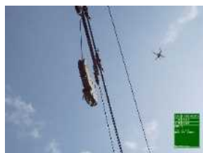
UAVによる索道設備の点検
