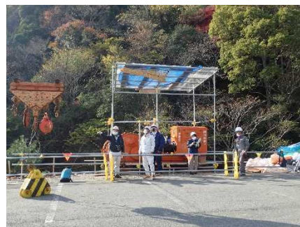
ケーブルクレーンでの資材吊り上げ
